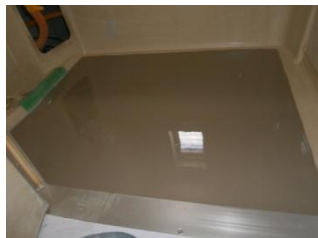
床パン強度補強(ゲルコート)
