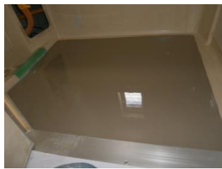
床パン強度補強(ゲルコート)
